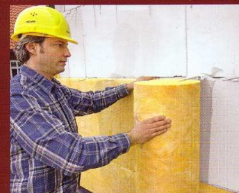
Praxistipp: Schnell und sicher dämmen
